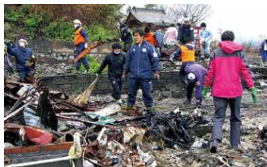
松本慎吾先生が引率する日体大レスリング部によるがれき撤去作業
